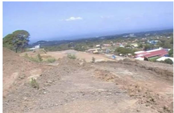
Foto 3 y 4. Remoción de la cubierta vegetal (malezas, arbustos) a través de maquinaria, en la parte más alta del costado oeste de Alvia Comercial. Foto CH/15 diciembre 2009.
