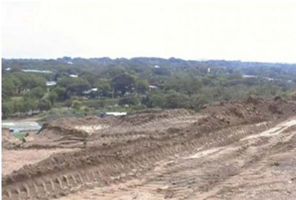
Foto 3 y 4. Remoción de la cubierta vegetal (malezas, arbustos) a través de maquinaria, en la parte más alta del costado oeste de Alvia Comercial. Foto CH/15 diciembre 2009.
