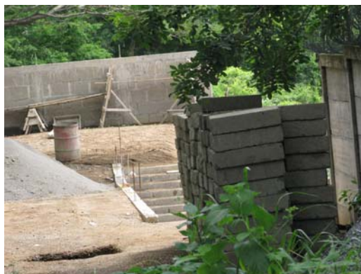
Foto 1. Construcción dentro de la zona núcleo, no se perciben avances significativos en la construcción. Foto CH/15 diciembre 2009.
