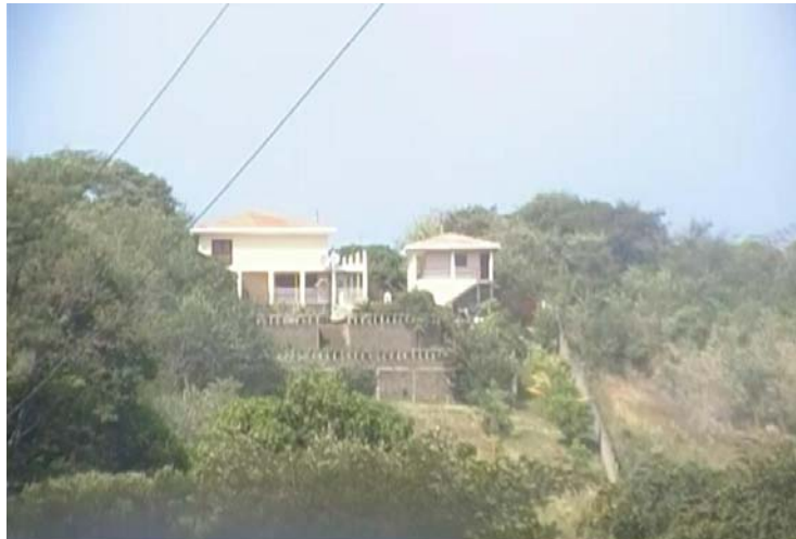
Foto 2. Construcción dentro de la zona de amortiguamiento, al costado sur de la zona núcleo. Foto CH/15 diciembre 2009.
